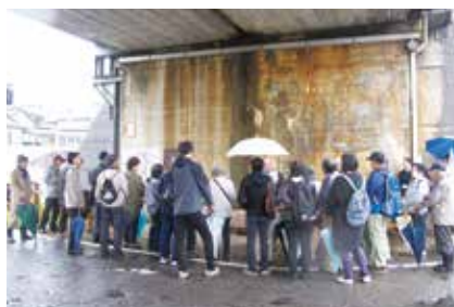
白金町交差点付近の高架橋下
