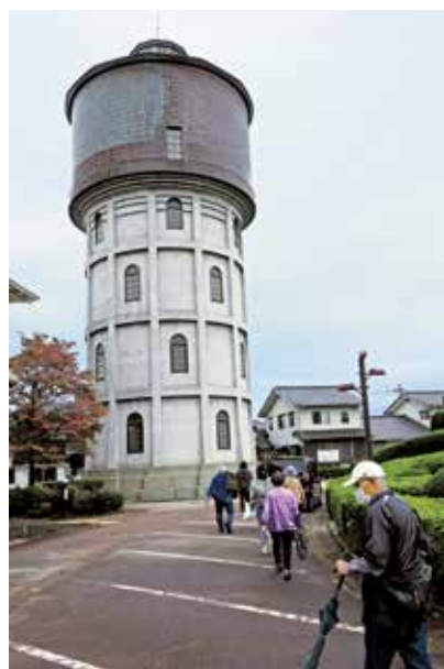
清水町配水塔
